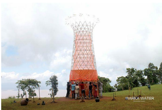
Рис. 3. Установка башни из бамбуковых ветвей
